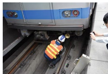
支援人員抵達，下軌道固定電聯車車下設備
