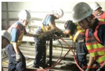
復軌組架設復軌頂昇機具
