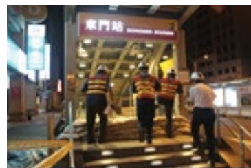
出口沙包鋪設完成，土建人員 抵達現場
