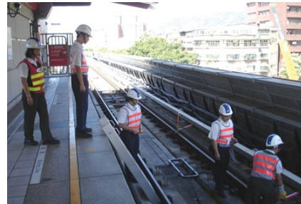
適應訓練之第三軌短路夾架設操作
