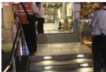
進行出口電動防洪門關閉
