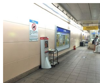
臺北捷運AED設備
