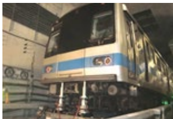
復軌組執行事故列車復軌頂昇作業
