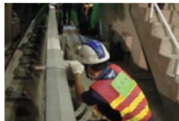
軌道組檢視導電軌損壞情況及維修作業
